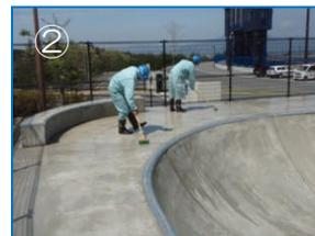
② 高圧洗浄機やブラシなどを用いて、表面にあるゴミ・砂などの汚れを除去し、清水で洗浄します。
