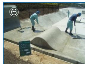
⑥ 高圧洗浄機、ブラシなどを用いて、表面にある余剰分を除去します。
