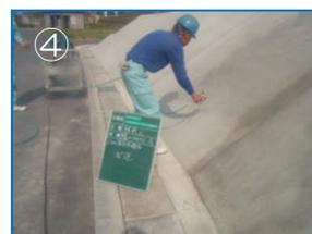
③④ 表面乾燥後、スプレーガン、ローラー、刷毛などを用いて均一に塗布します。塗布量 0.10~0.25kg/m<sup>2</sup>
