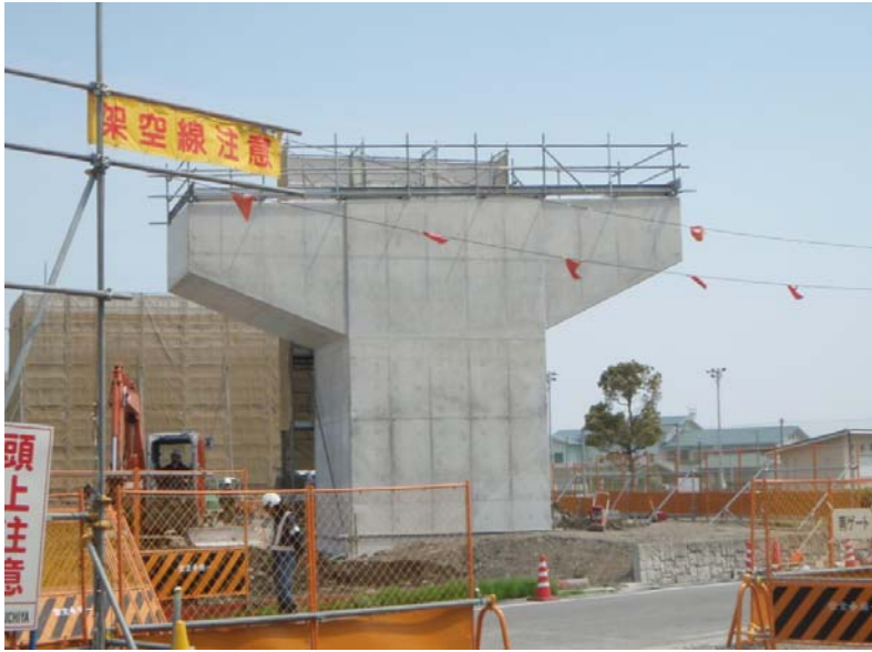
東海環状高架橋下部工事
