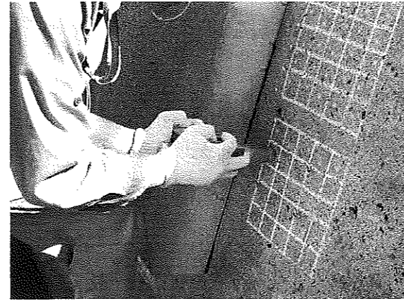
資料 写真-7.2.3 表面反発度試験状況(横向き)
